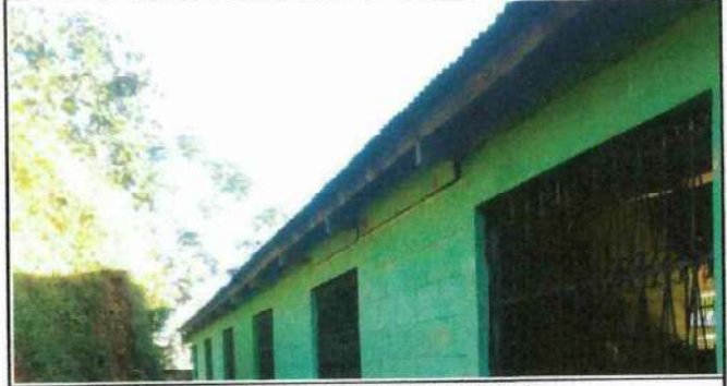
Foto 2: Se observa la estructura portante del modulo 1.
